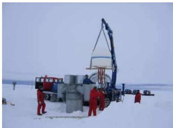
Das Bauteam bei der Arbeit (Foto: AWI, atkaXpress, Falk)
